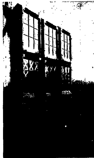
(d) Colonial windows in stacked arrangement.
