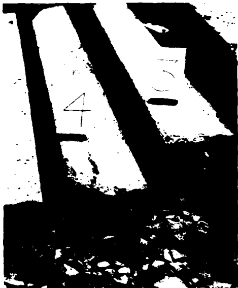
a. Beam 4, landward end
