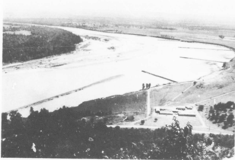
Fig. 16. Stone-fill dike system
