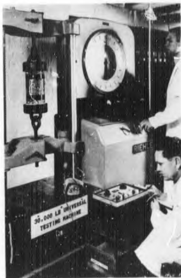
Fig. 2. Tensile test setup
