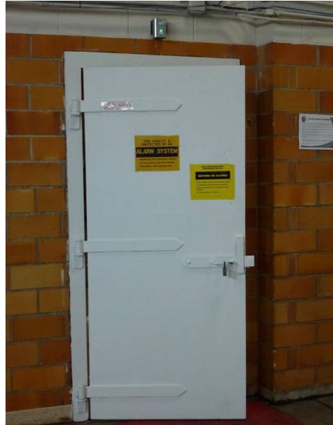
Steel supply room door (ERDC-CERL, 2014).
