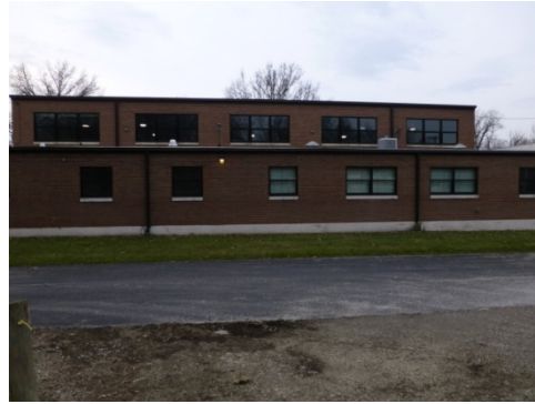
Repetitive window pattern (ERDC-CERL, 2013).
