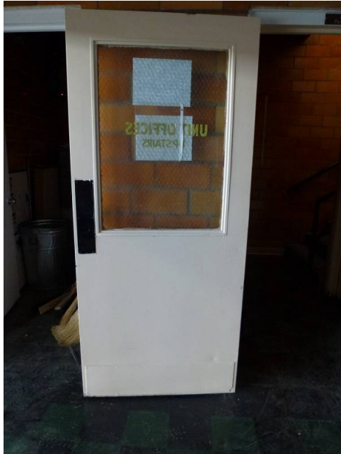
Metal and glass interior door (ERDC-CERL, 2014).
