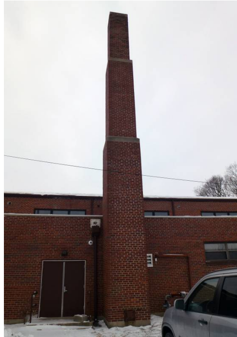
Brick chimney stack (ERDC-CERL, 2014).
