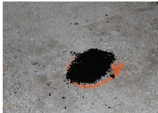
(d) Compacted prior to paving
