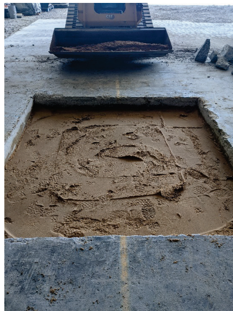
(d) Final sand layer prior to CSA placement
