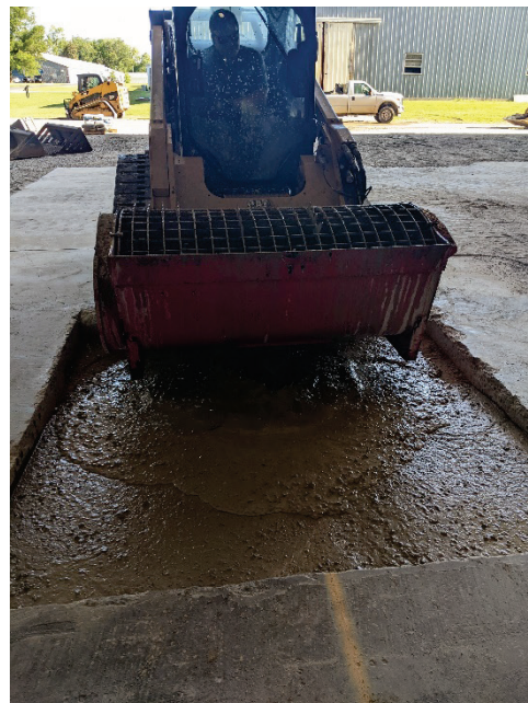
(d) Placement of CSA mixture into crater
