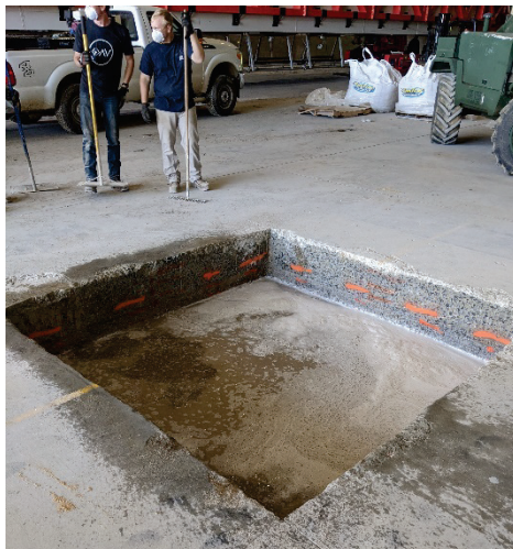
(d) Completed flowable fill lift
