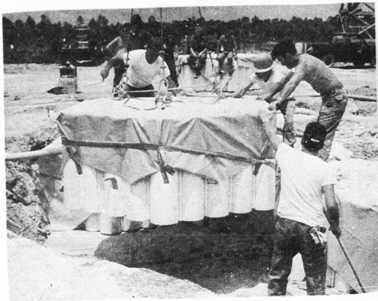
G. Placing Final Module in Top Layer
