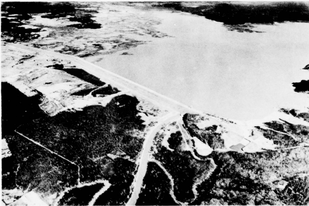
Grenada Lake and Dam.
