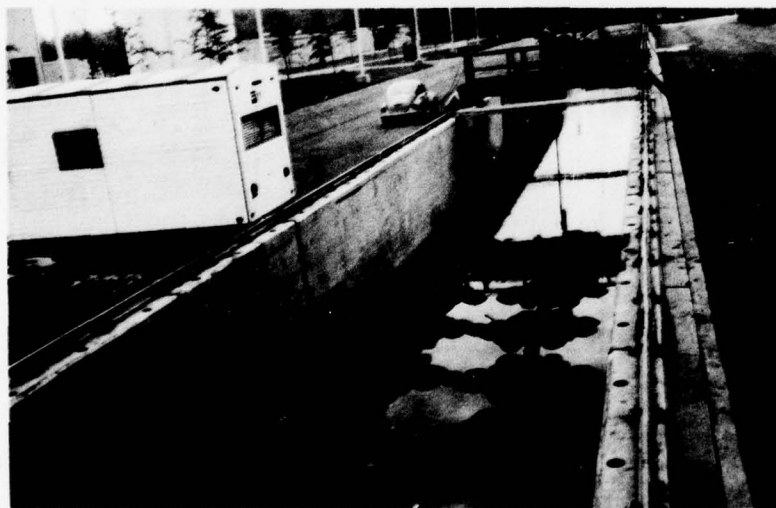
b. Twelve-module breakwater.
