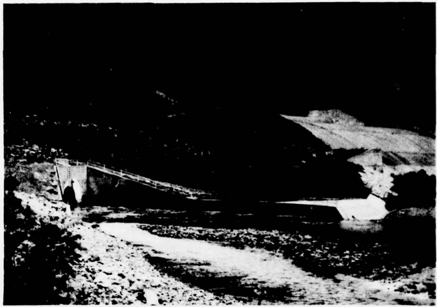
Conduit Outlet and Spillway
