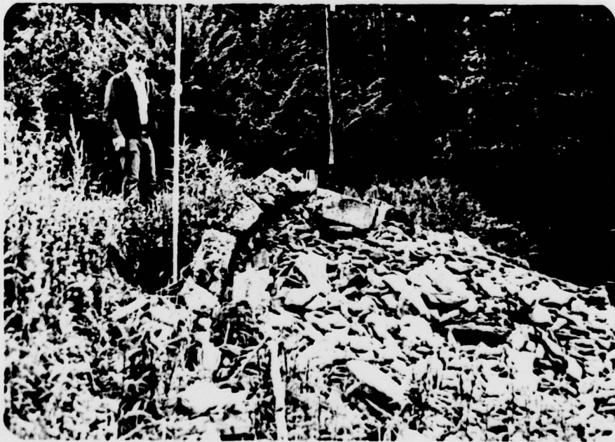
F. Breach Area
