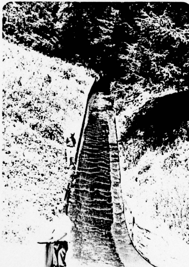
Bypass Conduit Outlet
