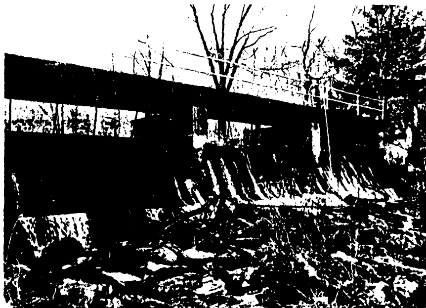
F. Spillway Weir and Apron.
