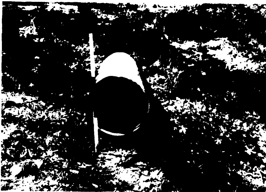
PHOTO 7 : SPILLWAY PIPE INLET
