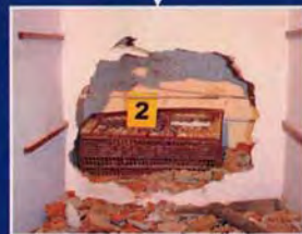
Caleta No. 3 ubicada en una falsa Pared de la cocina
