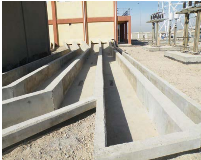
Cable tray interior.
