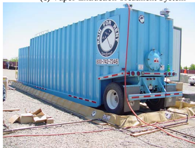
(d) 21,000-gal Wastewater Holding Tank
