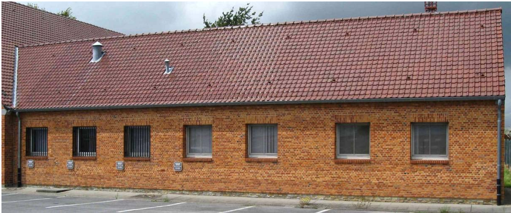
Figure 23. Bldg 10/Daumerie Caserne.
