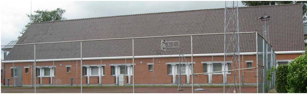
Figure 21. Bldg 6, Daumerie Caserne.
