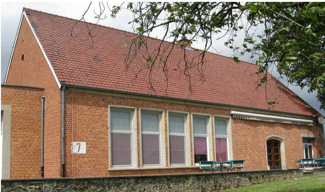
Figure 22. Bldg 7, Daumerie Caserne.
