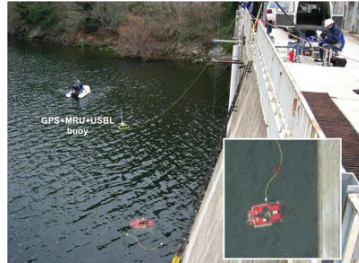
(d) Dam inspection
