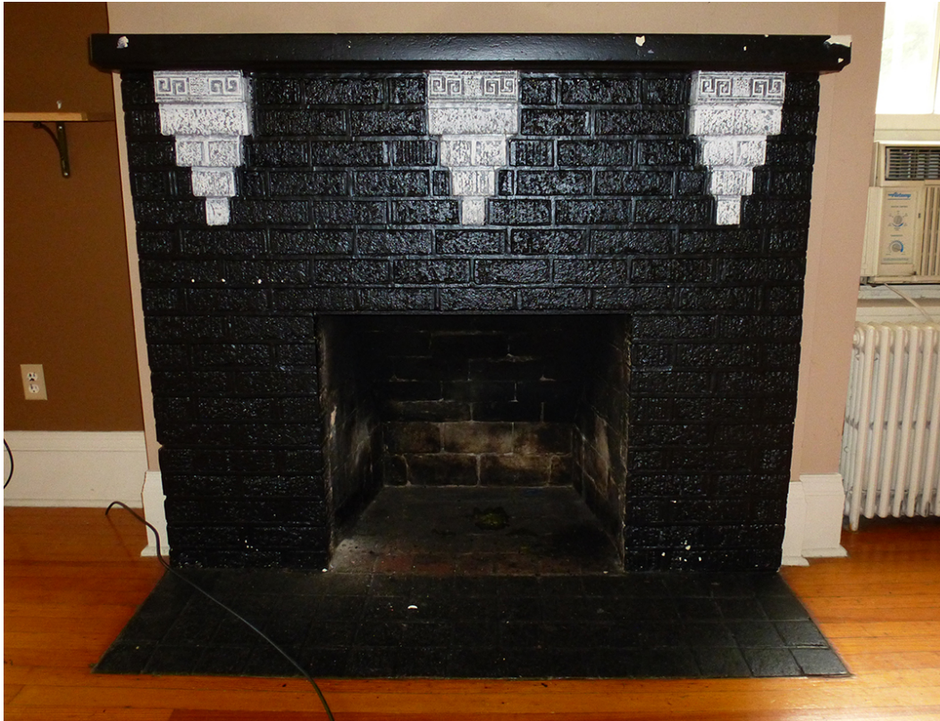
Figure 23. Living room fireplace surround (ERDC-CERL, 2012).
