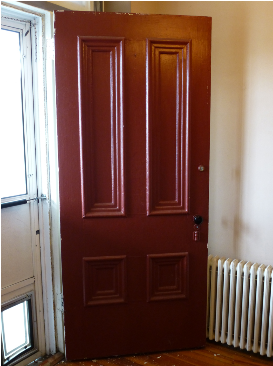
Figure 21. Front door (ERDC-CERL, 2012).
